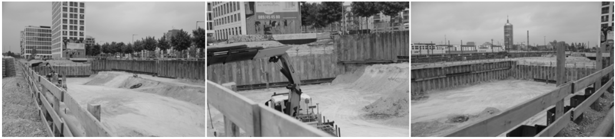
Abb. 6: Fotos eines Baustellenteils aus 3 Perspektiven
