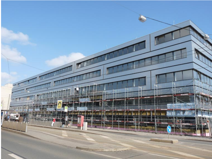
Abb. 10: Ansicht des annähernd fertiggestellten Gebäudes (fünfstöckig)
