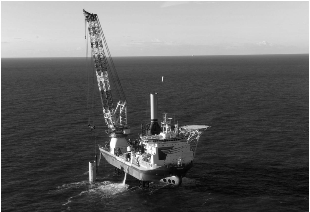
Abb. 3: Innovation bei Installationsarbeiten im Windpark Global Tech 1
