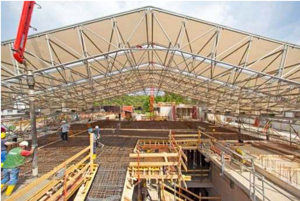
Abb. 1: Das Wetterschutzdach basiert auf dem LGS Fachwerkbindersystem und Systembauteilen des PERI UP Rosett Modulgerüsts. Die für dieses Projekt gewählte Dachneigung beträgt 15°. (© PERI GmbH)
