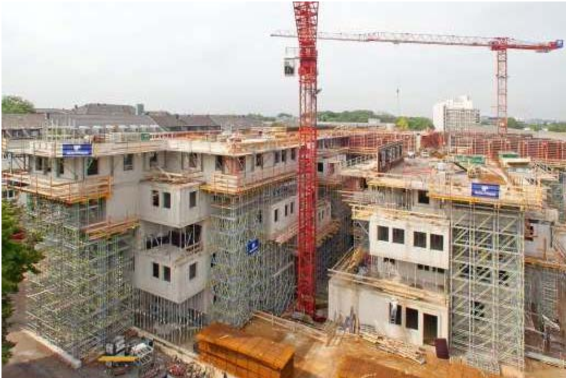
Abb. 4: Das bis zu 14 m hohe PERI UP Traggerüst wird mit dem Baufortschritt sukzessive fortgebaut und unterstützt die auskragenden Baukörper temporär, bis das Bauwerk seine volle Eigentragfähigkeit erreicht hat. (© PERI GmbH)
