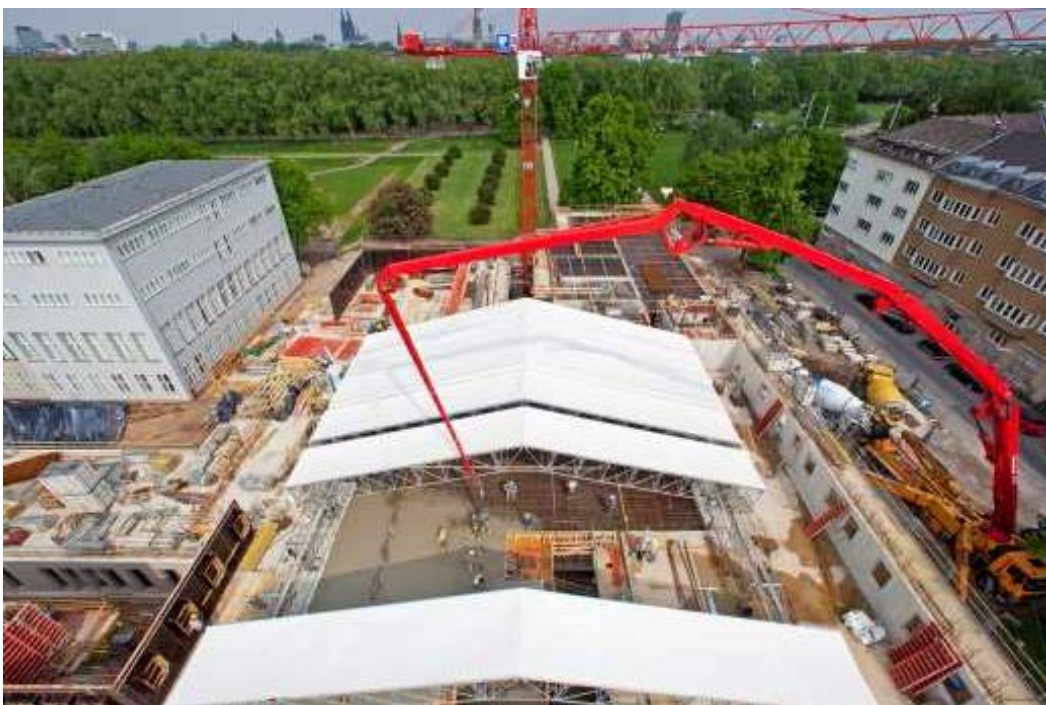
Abb. 2: Das LGS Wetterschutzdach lässt sich zum Betonieren und zum Einbringen der Bewehrung beliebig öffnen. Dazu können die Kederplanen in den Zwischenfeldern entfernt und die jeweils 3 m breiten Dachsegmente per Hand mittels eines Fahrwerks auf Fahrschienen verfahren werden. (© PERI GmbH)
