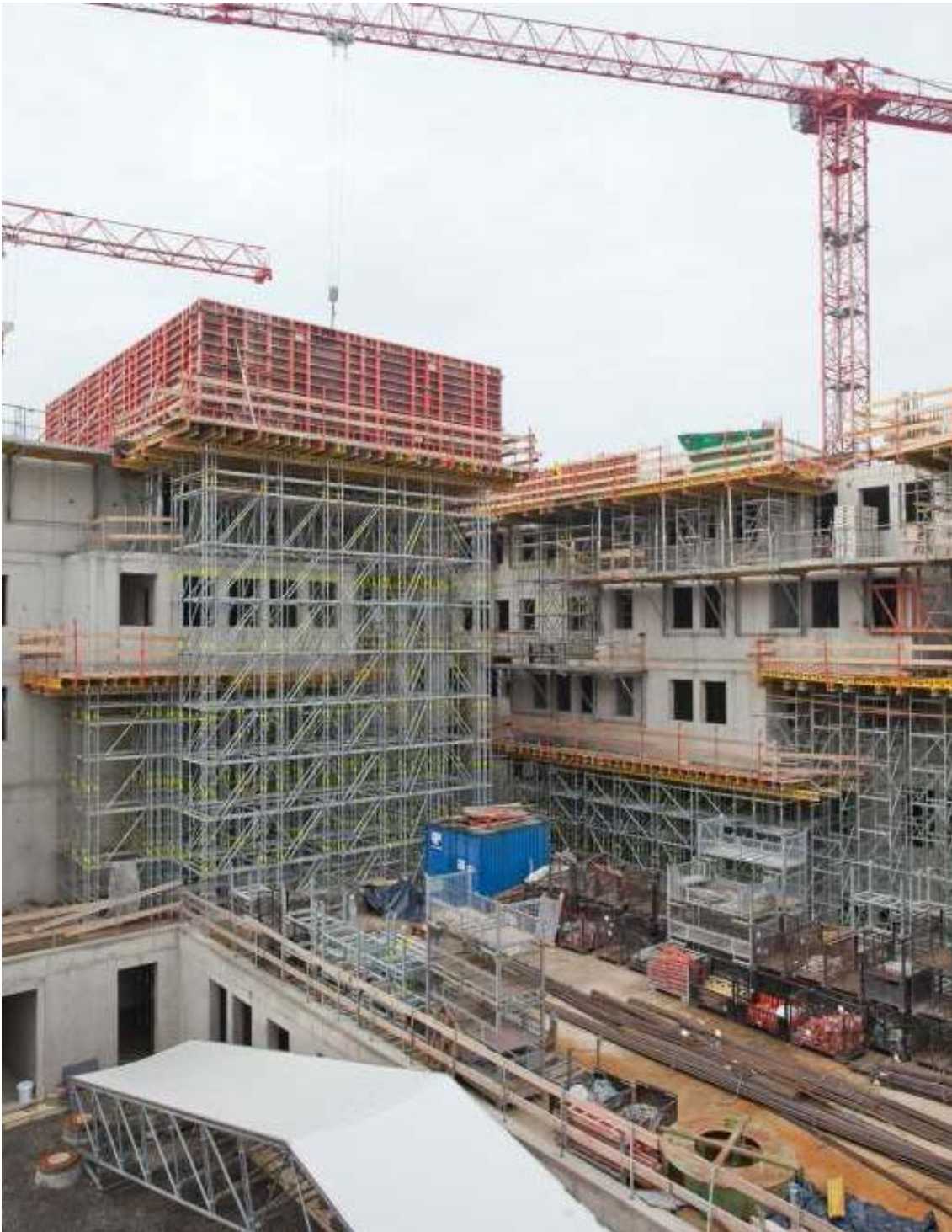
Abb 3: Der modulare Aufbau und das metrische Raster des PERI UP Modulgerüstsystems erlauben es, die Tragkonstruktion optimal an die Kräfte anzupassen. Bei punktuellen Lastkonzentrationen lassen sich mit kurzen 25-cm-Riegeln mehrere Vertikalstiele bündeln. (© PERI GmbH)
